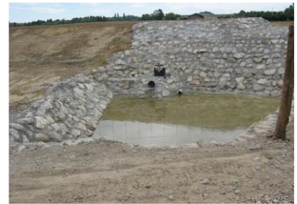
Exemple de consolidation de berges
